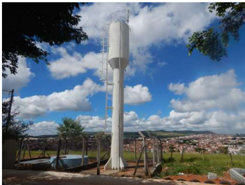
Foto 30 – Reservatório elevado Alphaville e elevatória GreenVille.
