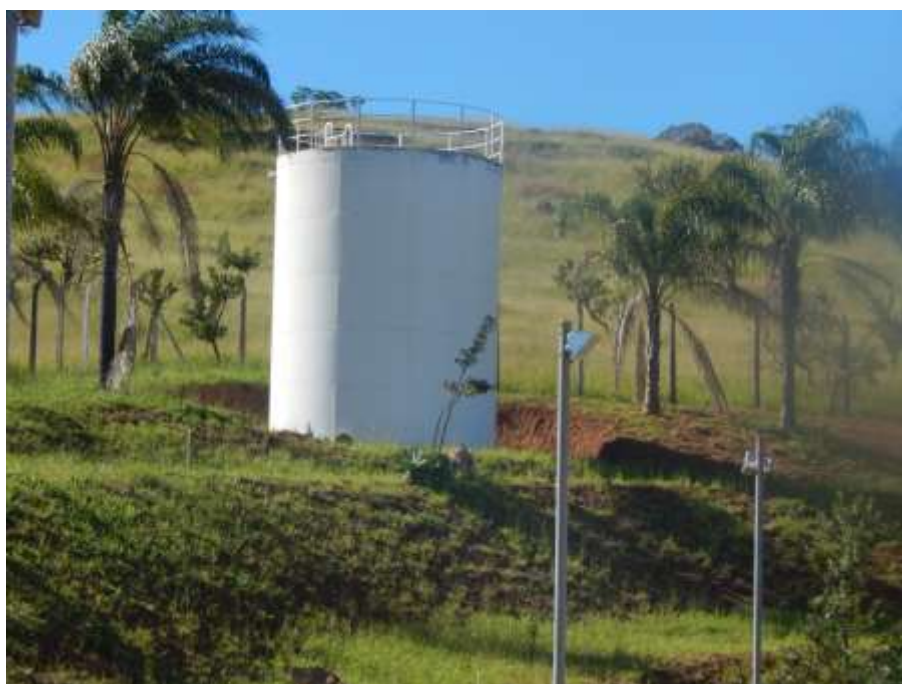
Foto 08 – Reservatório Apoiado - ETA II.
