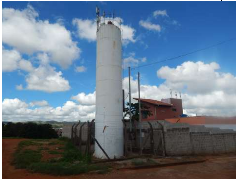
Foto 31 – Reservatório apoiado - Greenville.
