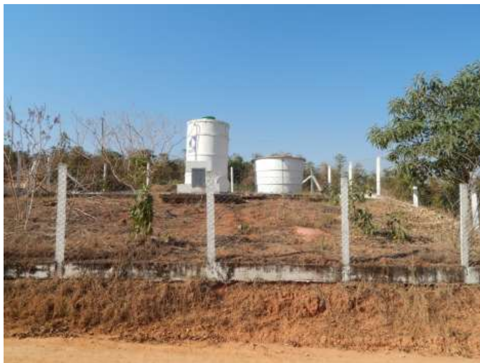
Foto 45 – Reservatório Apoiado I – Marmelada.
