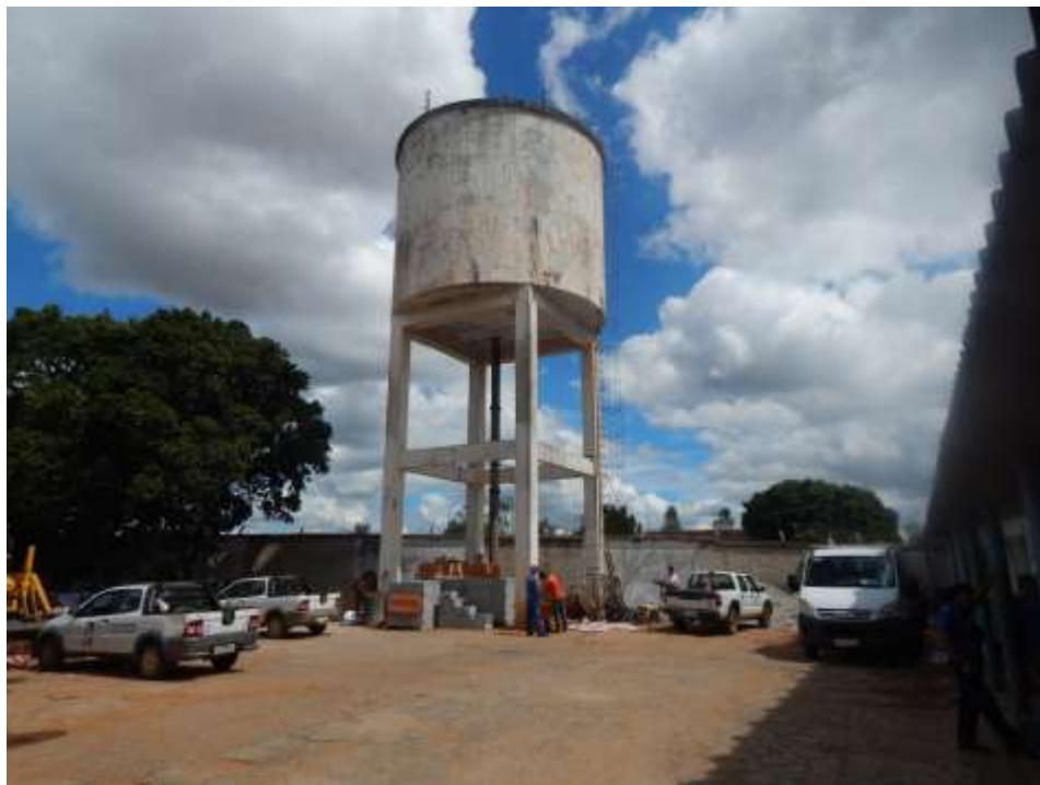
Foto 26 – Reservatório elevado - ETA I.
