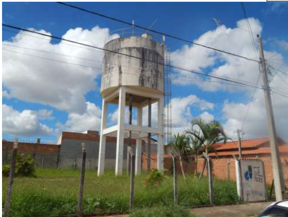
Foto 36 – Reservatório elevado – Cidade Jardim.
