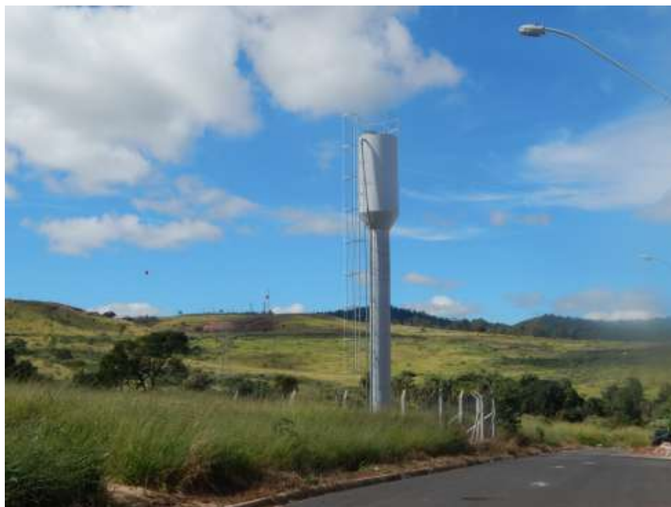
Foto 16 – Reservatório elevado – Aurora do Dia.
