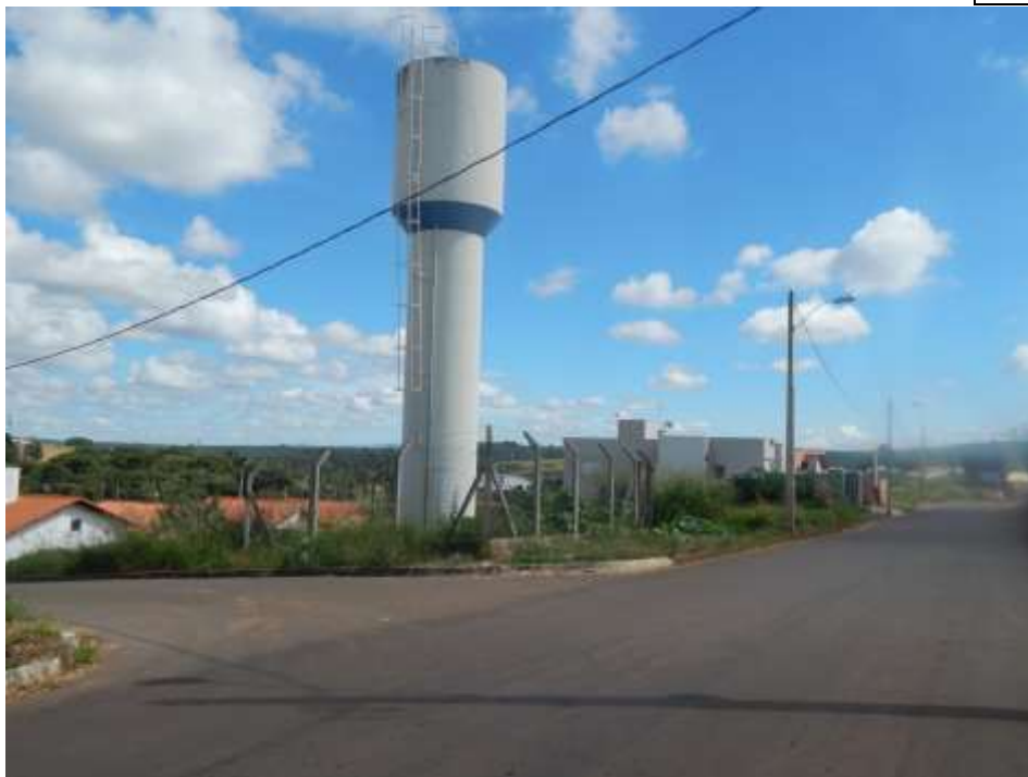
Foto 13 – Reservatório elevado – Olavo Lima.
