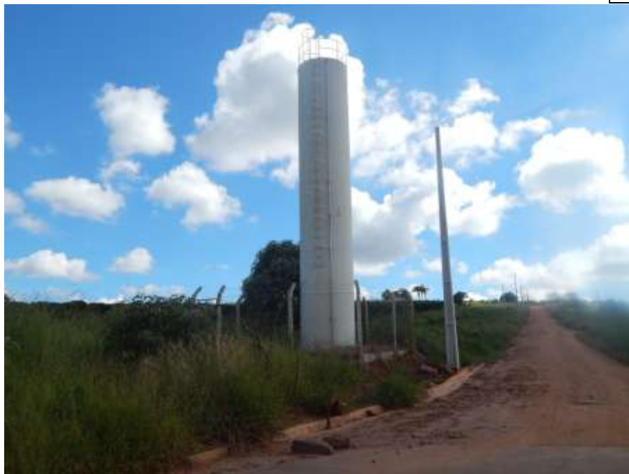
Foto 11 – Reservatório apoiado – Santa Tereza II.
