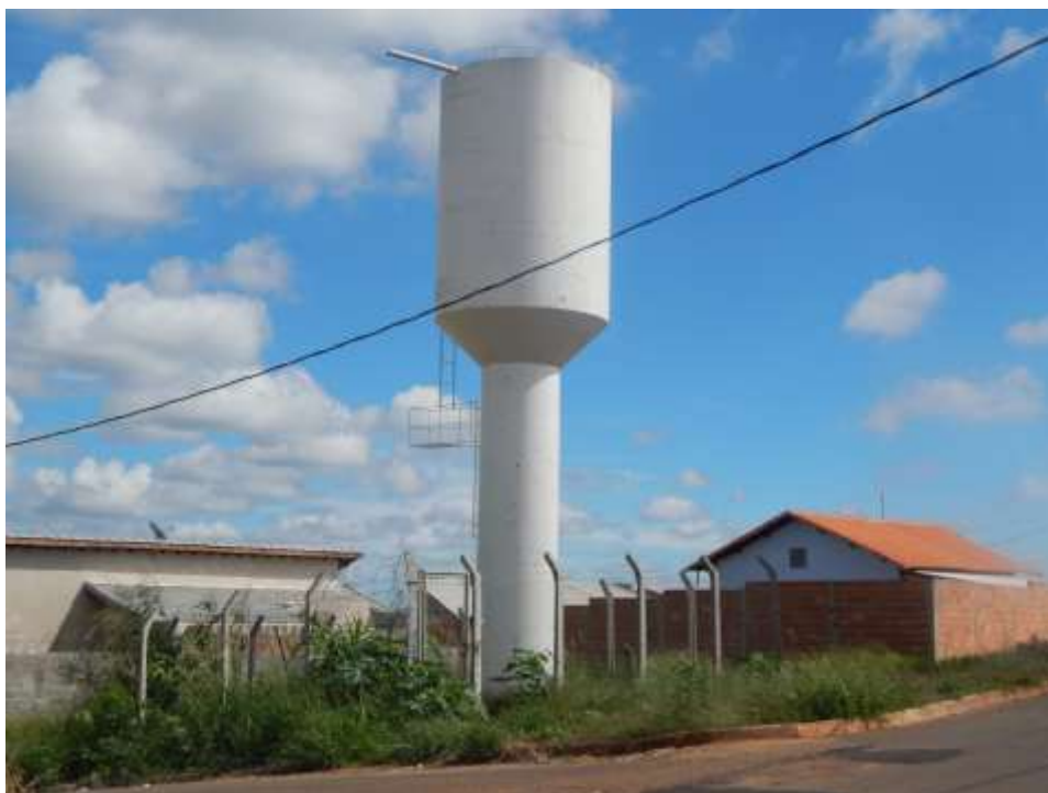
Foto 14 – Reservatório elevado – Vista Alegre.
