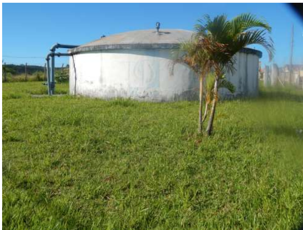
Foto 18– Reservatório apoiado – Ponte Alta.
