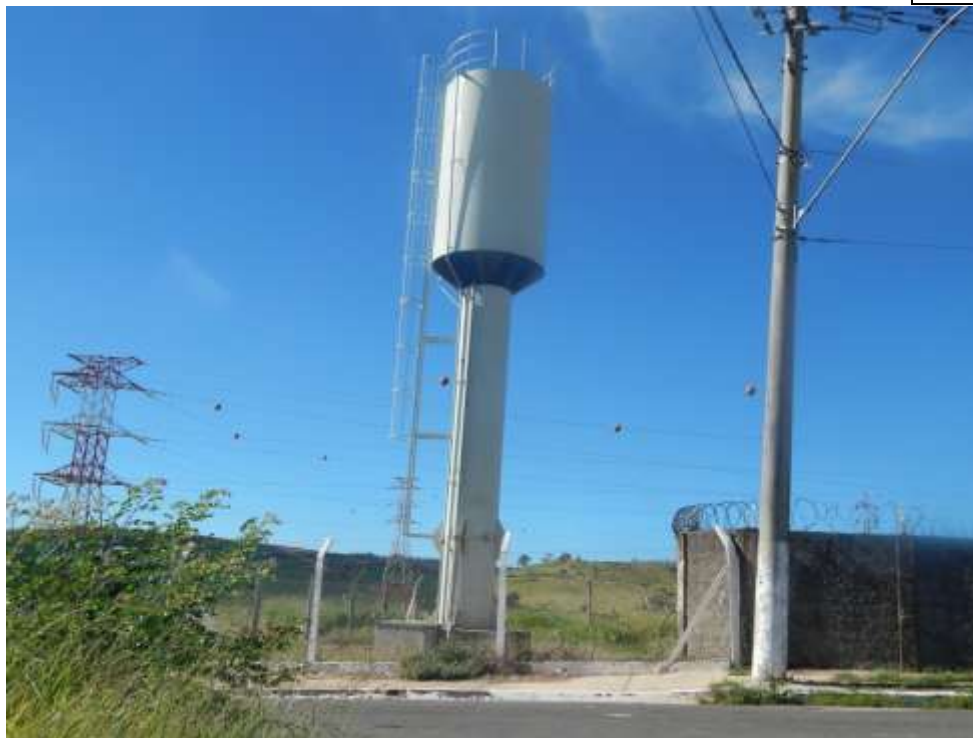
Foto 17 – Reservatório elevado – Vale do Sol.
