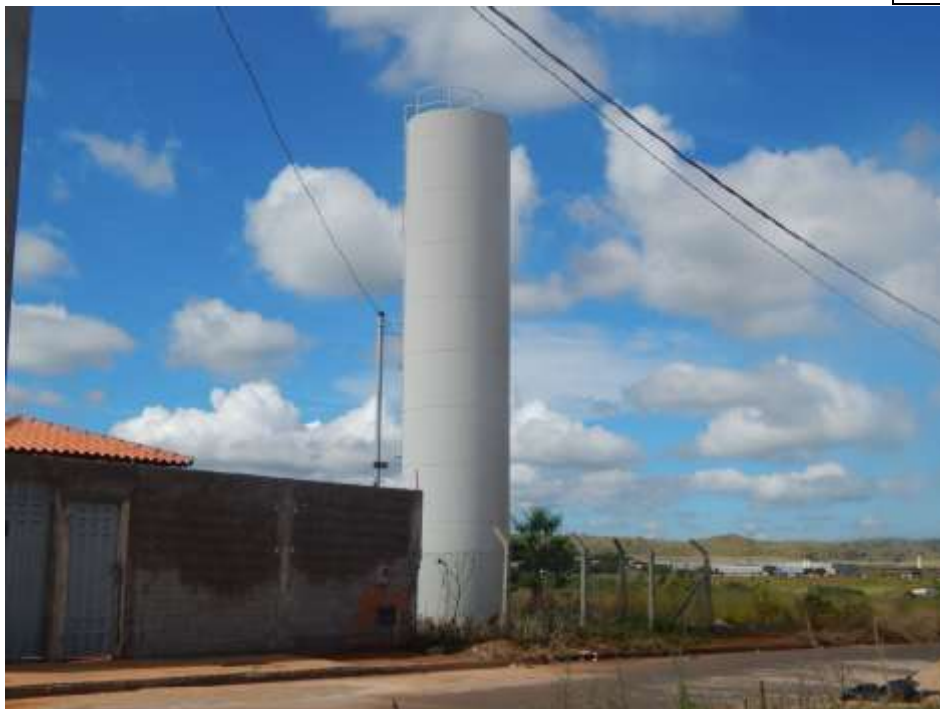
Foto 15 – Reservatório apoiado – Parque Brasil.
