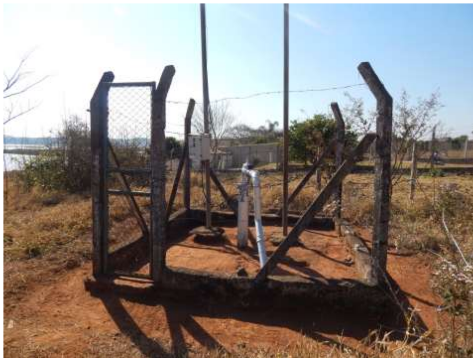
Foto 41 – Poço 1 – Distrito Pontalete.
