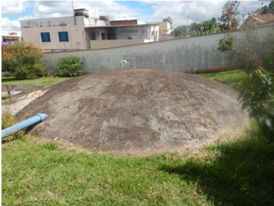
Foto 25 – Reservatório enterrado - ETA I.
