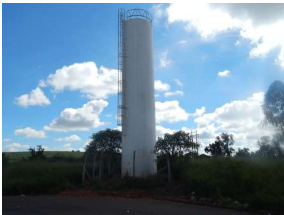
Foto 10 – Reservatório apoiado – Santa Tereza I.
