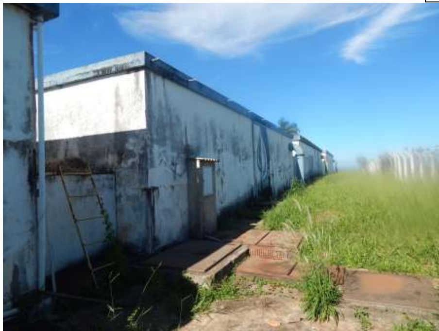
Foto 09 – Reservatório Semi enterrado e bomba 10 cv - ETA II.
