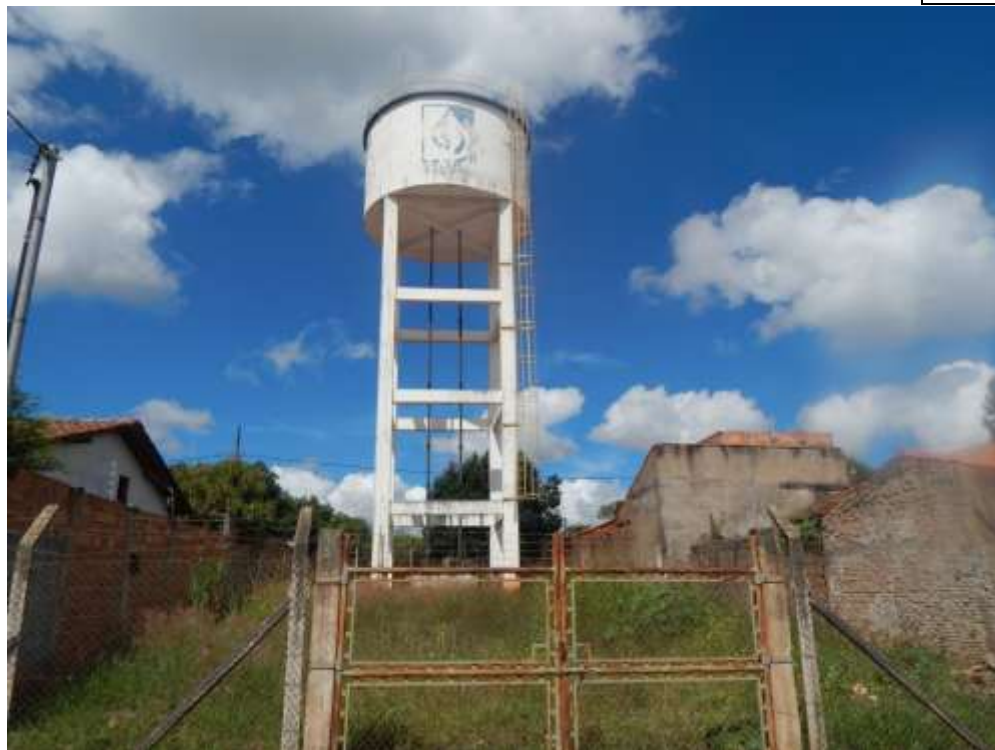
Foto 29 – Reservatório elevado - Santana.
