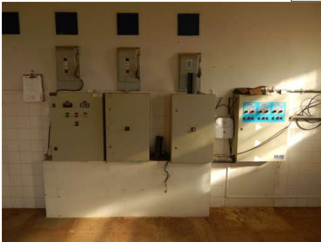
Foto 23 – Pannel de comando (partida direta) EAB 1 – Quatis/Formiga.
