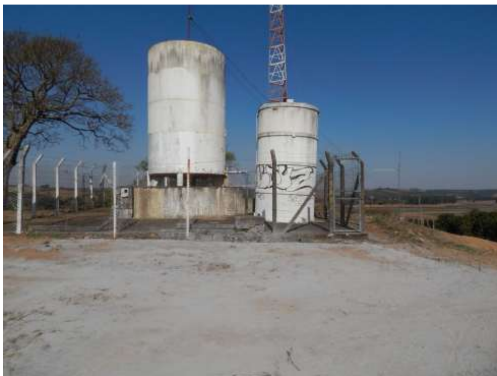
Foto 43 – Reservatório Apoiado I – Distrito Pontalete.
