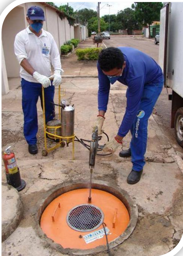
Trabalhadores em vistoria em rede coletora
