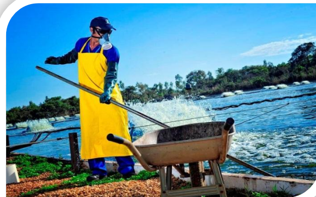
Manutenção na ETE
