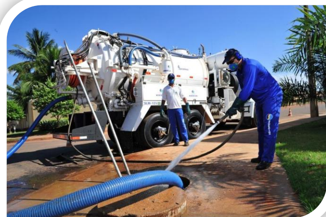
Desobstrução de rede de esgoto
